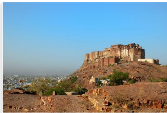
Forteca Mehrangarh, Dżodhpur
